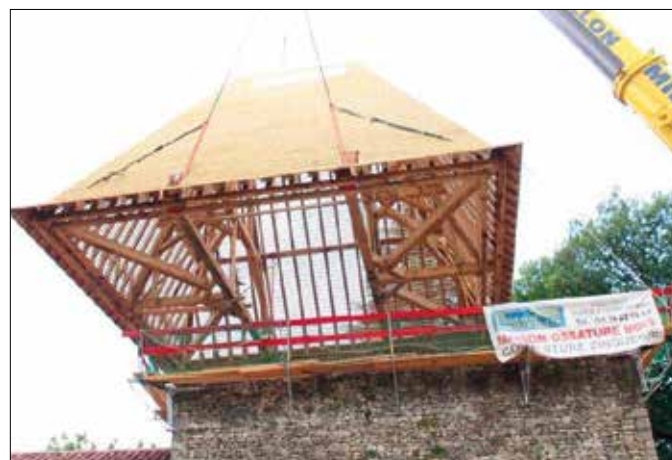
Reconstruction à l'identique d'une tour du château de la roche à St Martin du mont (charpente en chêne)
