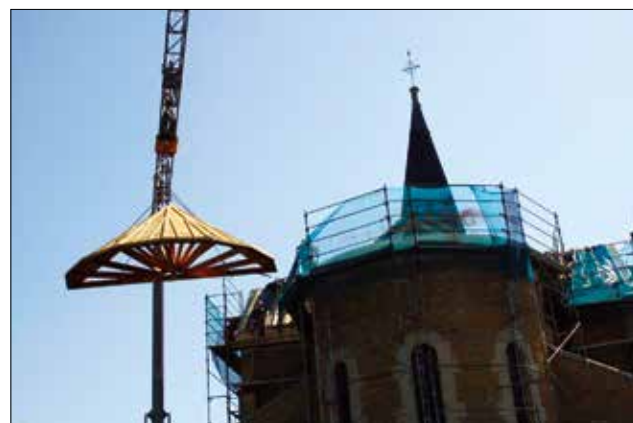
Réalisation d'un absyde pour l'église de St Julien sur Reyssouze
